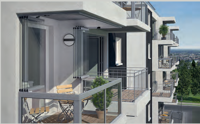
Остекление балконов и фасадов Balcony and Facade Glazing
